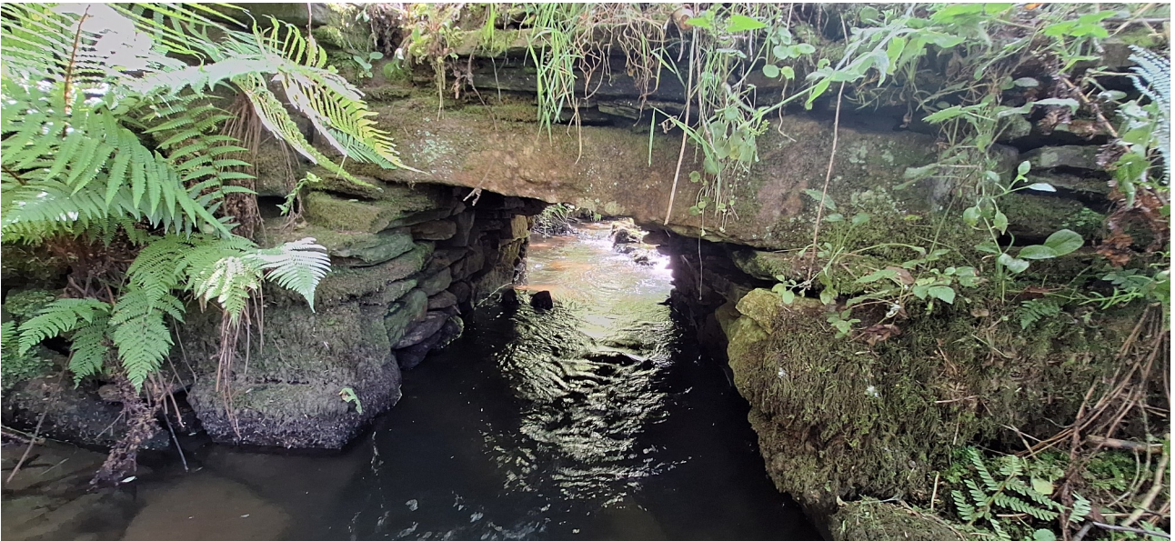
Pequeño puente de piedra, rústico y artesanal, por el que el camino salva el arroyo
