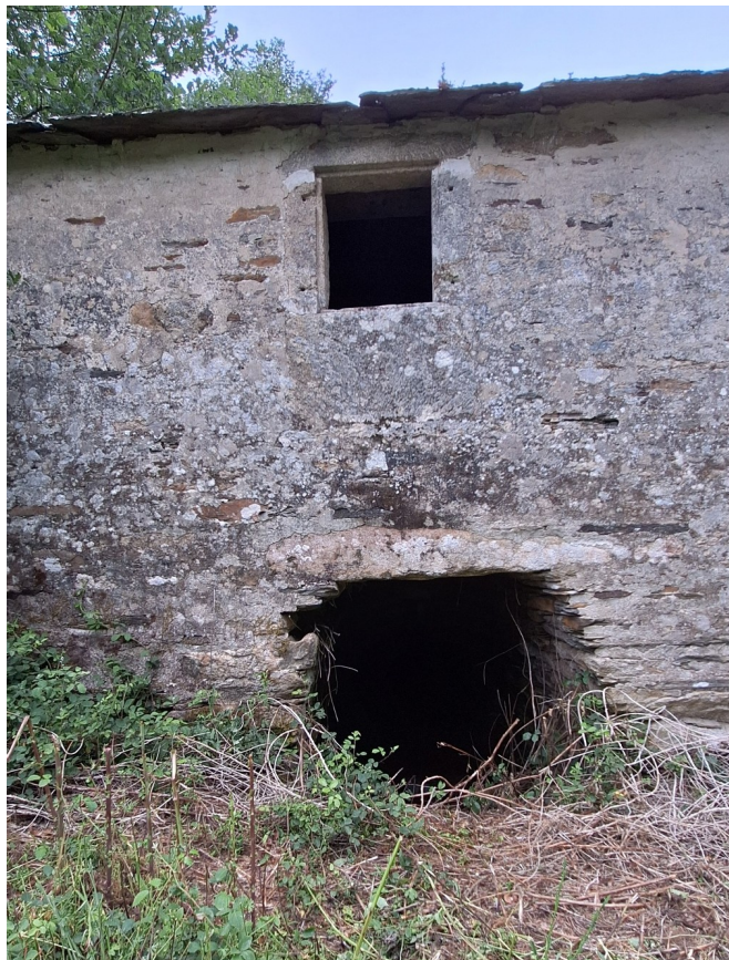
Fachada sur, con la ventana y la cavidad que albergaba el rodicio 18
